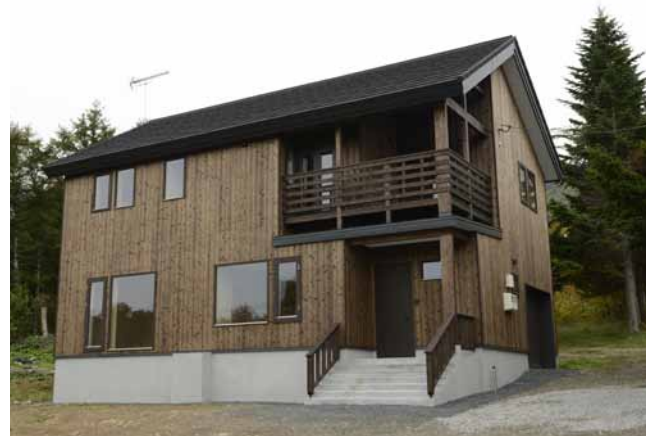
Tさんの故郷、岐阜の古民家をお手本に、三角屋根と木の外壁、玄関ドア、窓枠を採用した新居。歳月を経るほどに、外観もまた豊かな味わいを醸し出すだろう
