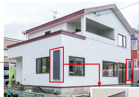
赤線で囲んだ部分に設置されているのがソーラーウォーマー
